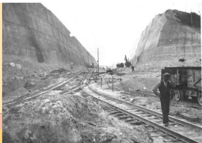
Aanleg van het Albertkanaal tussen 1929 en 1939.
